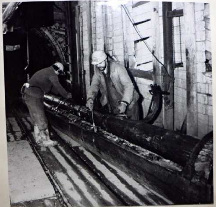
K DOPRAVĚ MATERIÁLU SE POUŽÍVÁ MATERIÁLOVÉHO VĚTU
